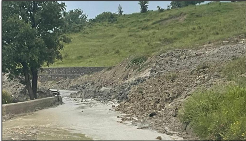
Fig. 1.2.8. Giugno 2023 – Pietrapertosa: una frana, ha bloccato per qualche ora la strada che collega Pietrapertosa con la Basentana. Il territorio è caratterizzato da frane per: colamento lento che coinvolge terreni di riporto, flysch, calcareo-marnosi, scivolamento rotazionale / traslativo in terreni di riporto e aree con frane superficiali diverse in argilliti, siltiti, flysch pelitici.
