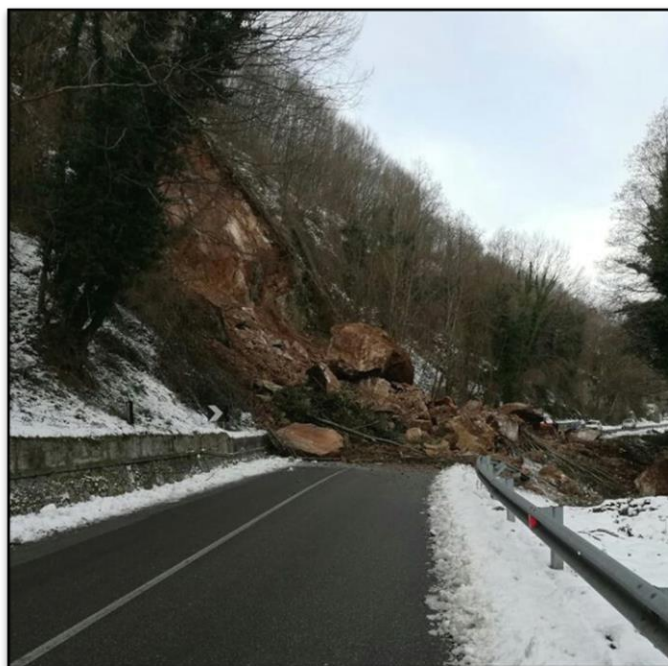
Fig.1.2.6. - Frana Galdo – Lauria (Pz): 14/01/2019 - Una frana ha interrotto la statale 19 in prossimità delle contrade Piano Menta – Monte Galdo, in un'area con frane superficiali diffuse che coinvolgono terreni a: argilliti, siltiti e flysch pelitici.
