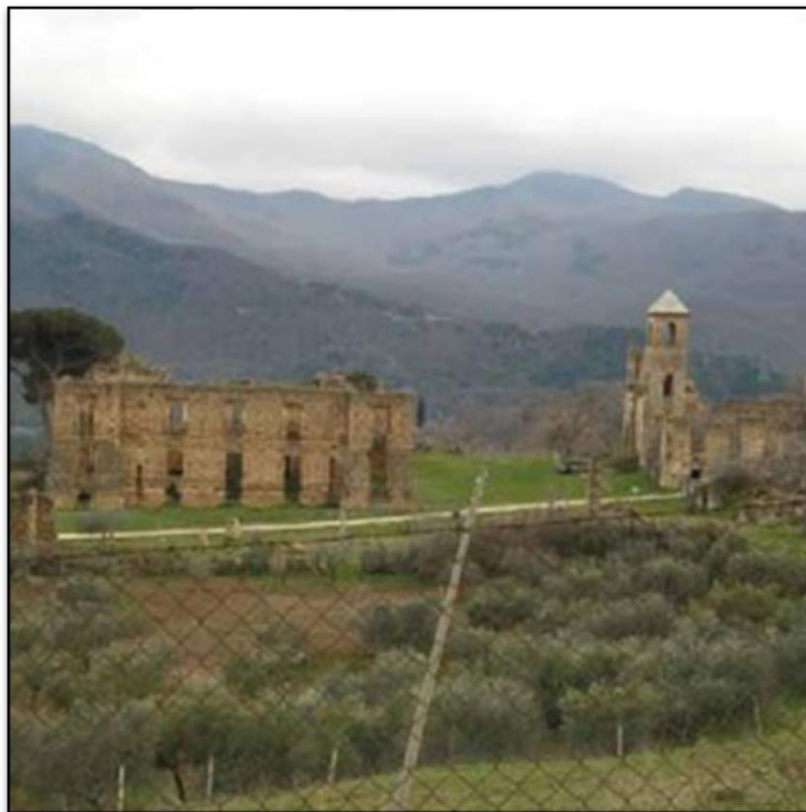
Fig. 1.2.9.b. - Edifici di Campomaggiore vecchio inclinati verso monte
