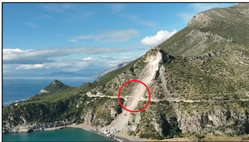
Fig. 1.2.11. - Frana di Maratea (30 novembre 2022): scivolamento rotazionale/traslattivo – detriti e frango, chiusa la SS18 (nel cerchio rosso un tratto di strada coinvolto dalla frana). Il territorio è caratterizzato da frane per colamento lento in terreni prevalentemente argillosi, frane da crollo / ribaltamento in rocce carbonatiche, frane per scivolamento rotazionale / traslazionale in detriti, e aree con crolli e ribaltamenti diffusi in argilliti, siltiti e flysch pelitici., detriti.
