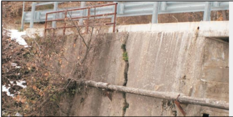
Fig. 1.2.7.b. - Foto del 2009: esempio di danni alle infrastrutture riconosciuti al di sopra della strada principale
