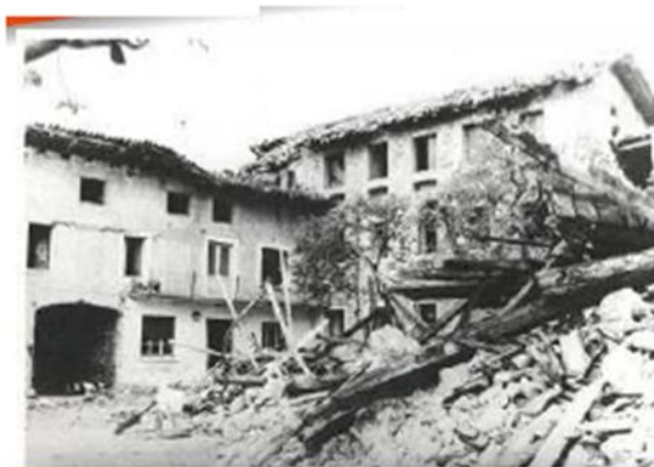
1976 Terremoto del Friuli
