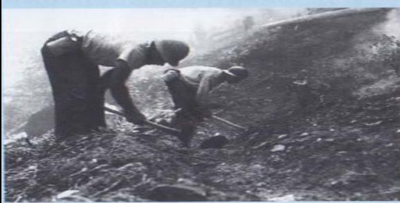
Realizzazione di una fascia di controllo lungo un versante, con preparazione di una trincea in contropendenza per evitare che il materiale in fiamme rotoli giù per il pendio (Completing the fire line MT. 1953 — U.S.D.A. Historical Fire Photos).
