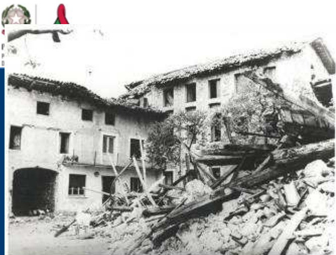
1976 Terremoto del Friuli
